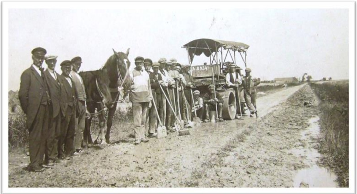
Aanleg Schaaapweg te Westernieland, ongeveer 1920. Derde van links: Klaas Snitjer, aannemer, geb. 08- 02- 1886, overl. 17- 12- 1963. Eerste van rechts: Johannes (Jans) Huizinga, walsmachinist, geb. 02- 07- 1888, overl. 19- 02- 1972. Huizinga liep altijd op klompen van Van der Meulen.
